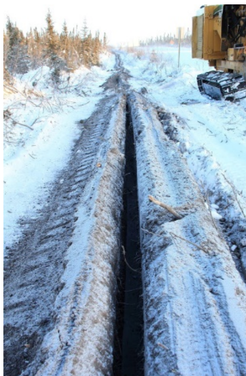
Figur 13 Kablene må behandles meget forsiktig ved lave temperaturer.
